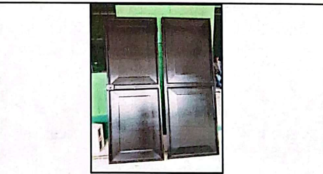
Foto 6: MANTENIMIENTO DE 9 PUERTAS
